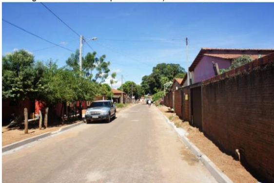
Figura 35 - Vias recém pavimentadas, no Setor Maria Galvão.
