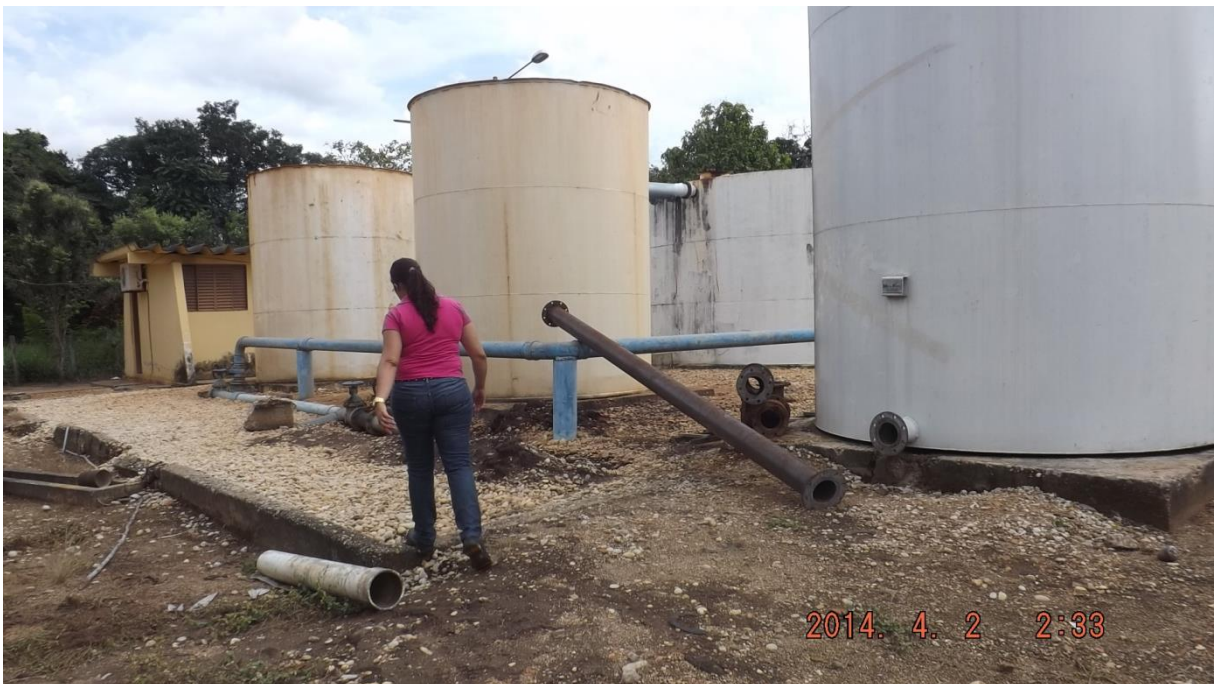
Figura 08 - Filtros da ETA.
