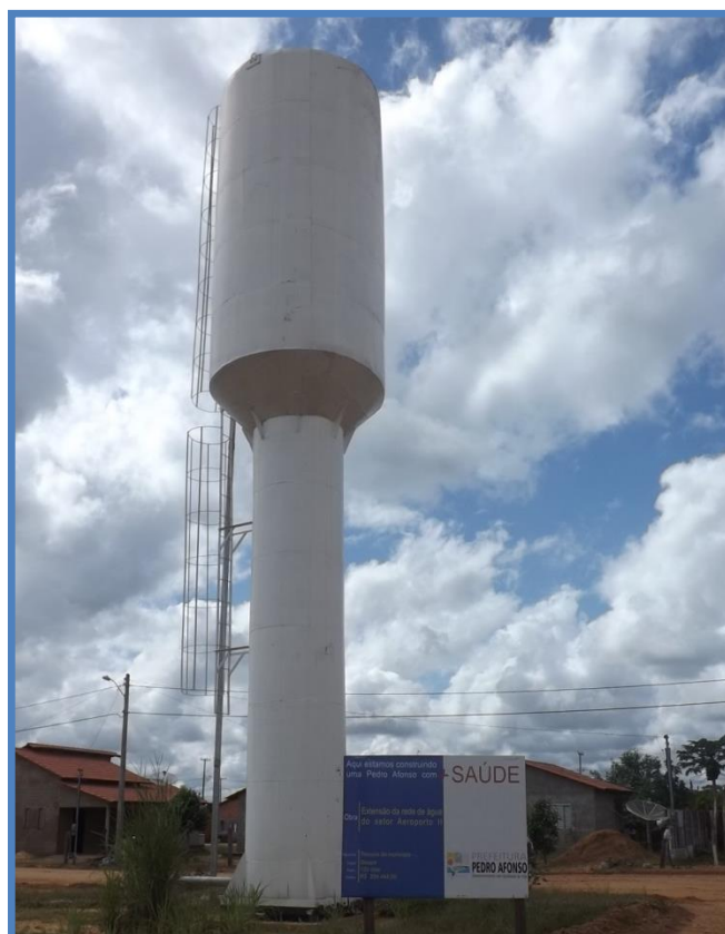
Figura 14 - Reservatório (Tipo Taça), localizado no Bairro Aeroporto 2.
