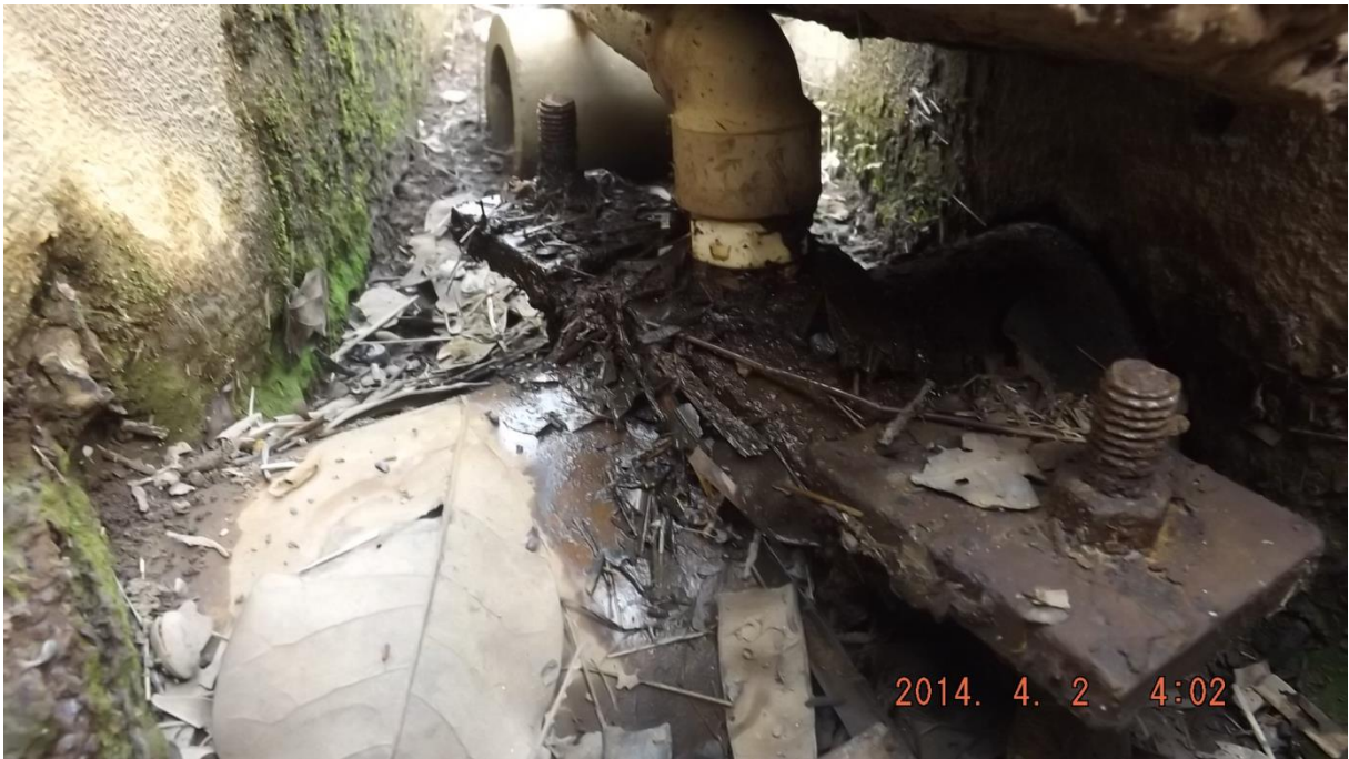
Figura 07 - Local de aplicação do sulfato de alumínio.
